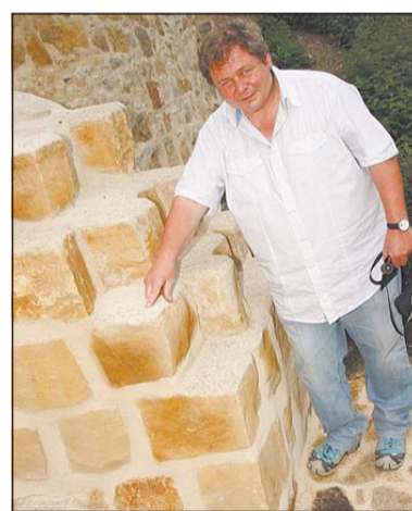
Gerd Belk zeigt die neue Südmauer der Burg Ravensberg.
